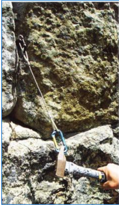
استفاده از ابزار میخ کش و تست میخ نصب شده
